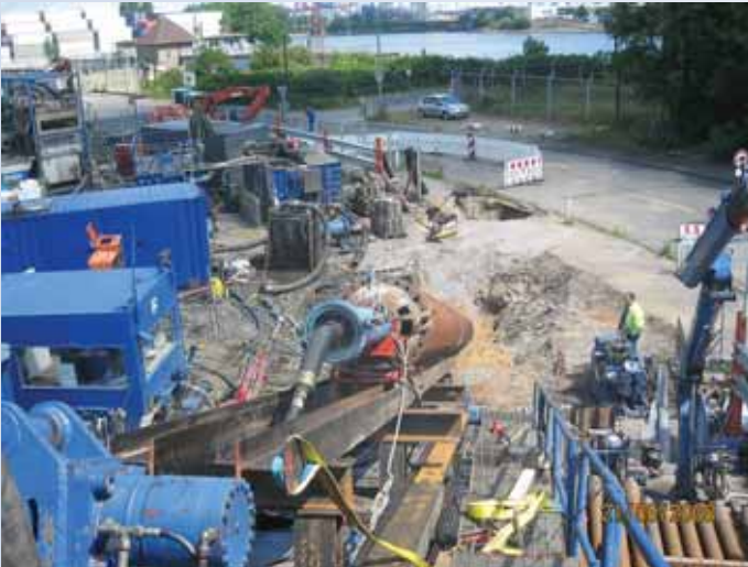
Ein Blick vom Rig der Bohranlage
