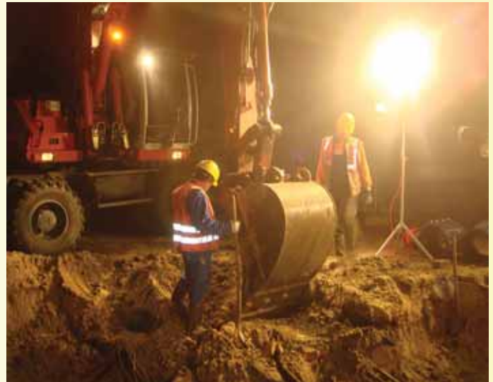
Vorsichtiges Graben bis zur Schadstelle
