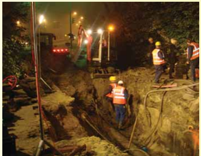
Der Austausch des defekten Rohrsegmentes kann beginnen
