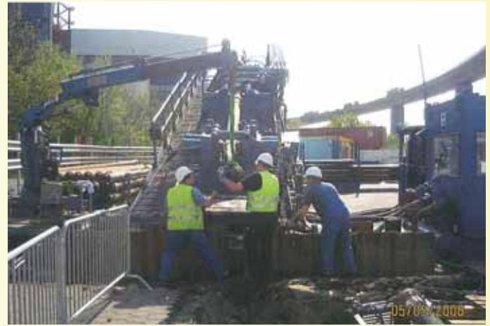
Einrichtung der Bohranlage 140 to
