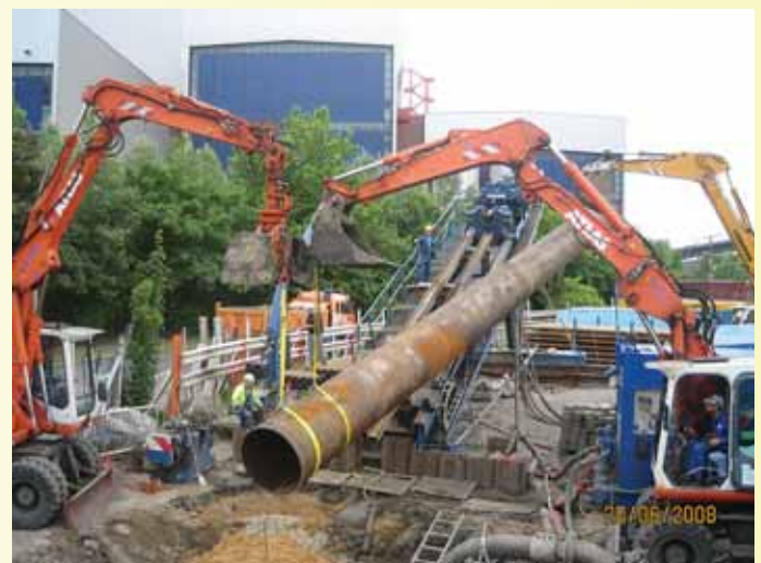
Positionierung des Casing-Rohres
