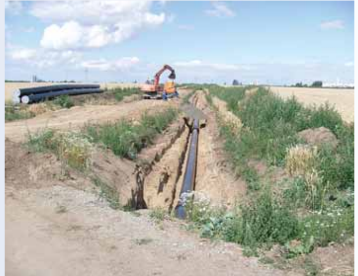
Rohre werden verlegt
