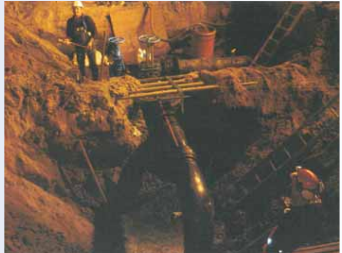
Umschluss nach 2 Druckrohrleitungen, morgens um 1 Uhr
