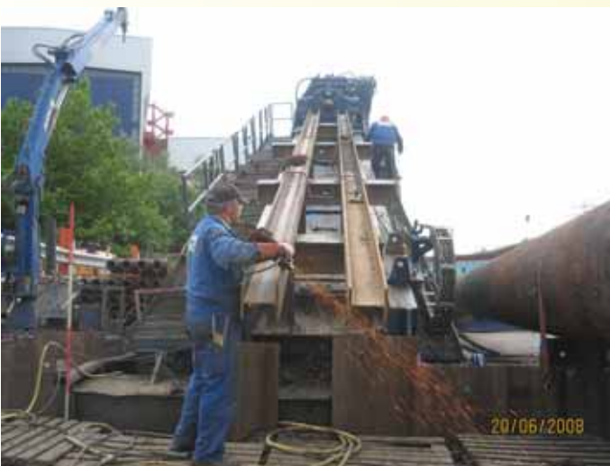
Umbau der Bohranlage für die Rammung
