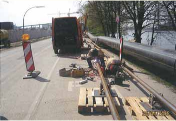
Trassierung des Rohrstrangs für die erste Bohrung
