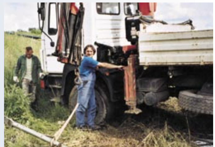
Geschafft: 270 m zielgenaue Pilotbohrung
