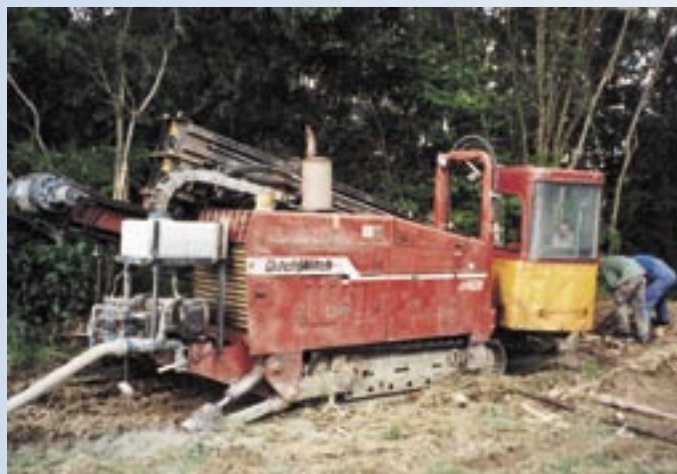
Einrichten der Maschine zur Pilotbohrung
