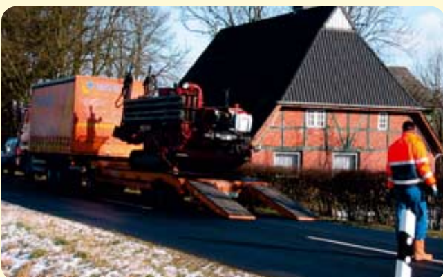
Wähler Spezialtiefbau Winterbaustelle wird zum Großprojekt
